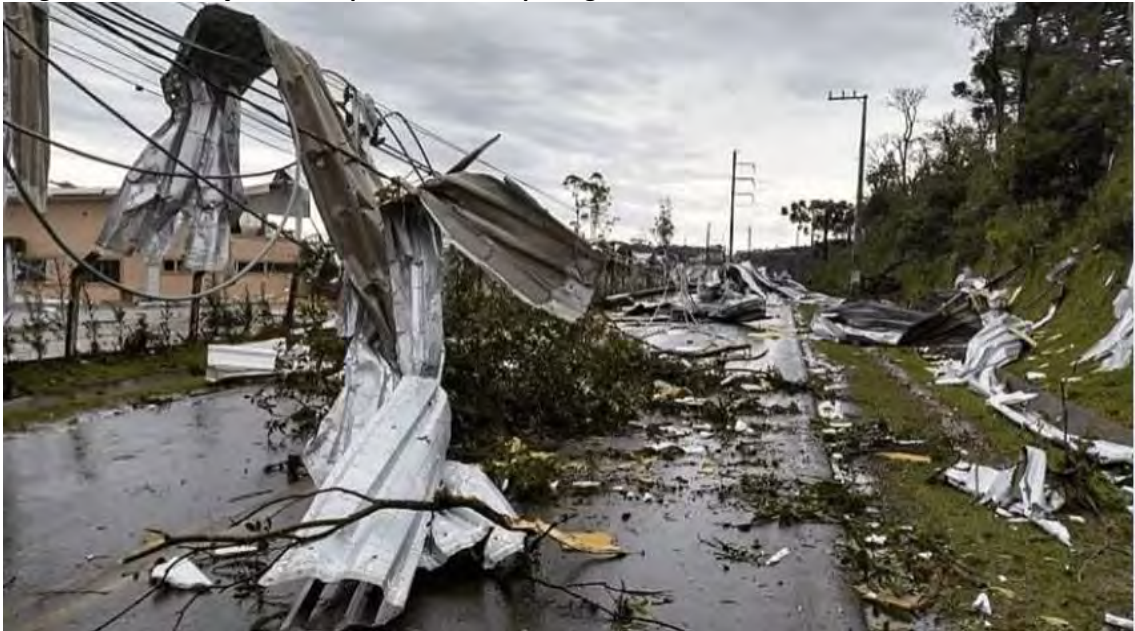
Figura 13 - Destruição em Chapecó durante a passagem da linha de instabilidade do ciclone bomba.
