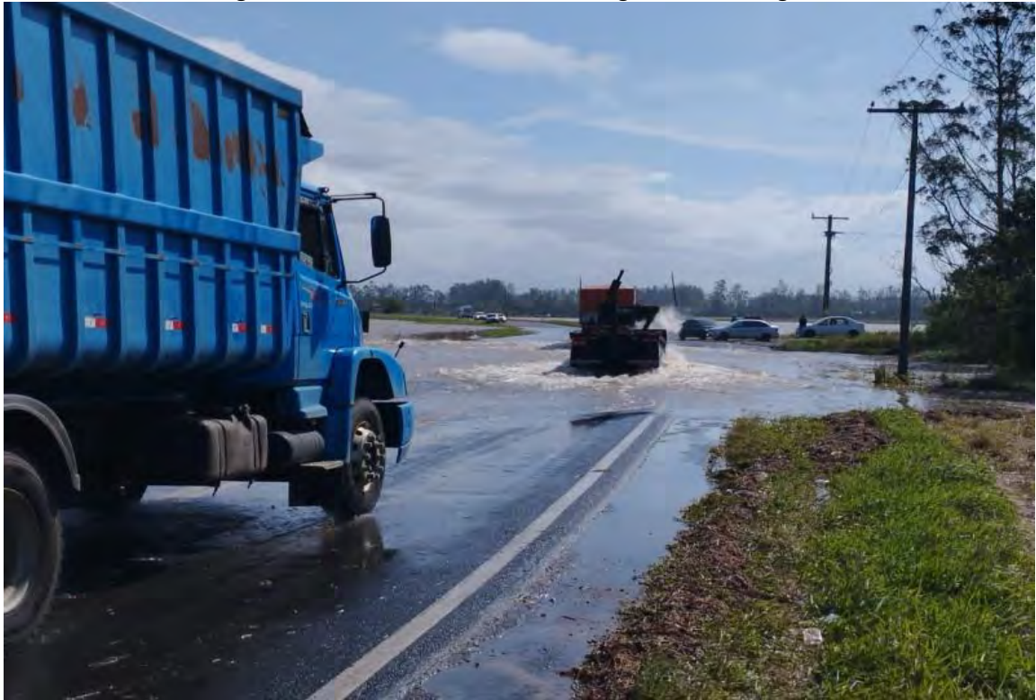
Figura 11 - Trecho da rodovia SC-447 alagado em Araranguá.
