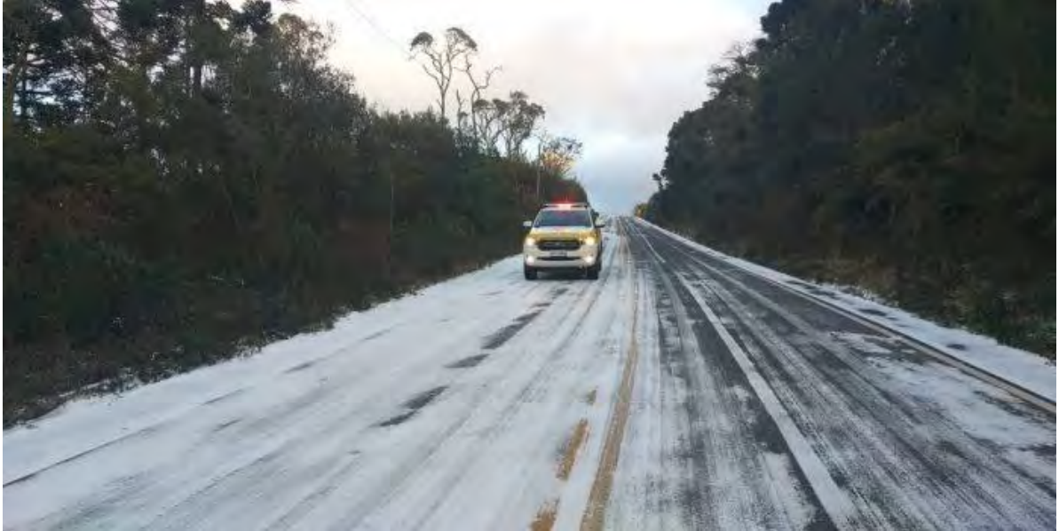
Figura 15 - Gelo na pista da rodovia SC-114 entre Paineira e São Joaquim.
