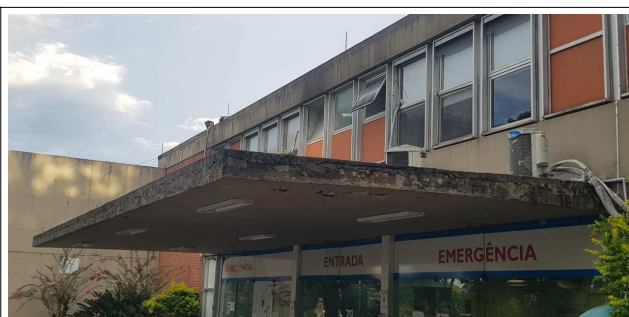
Marquise _ Emergência Laje em balanço de 4,90 m
