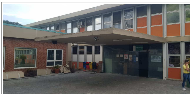
Marquise_ Ambulatório Laje em balanço de 6,90 m
