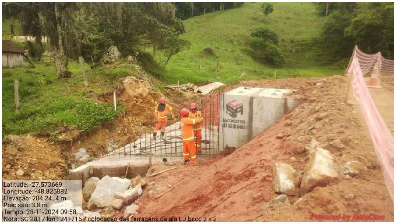
Foto 2 – Execução de Ala BSCC 2,00 x 2,00 – 24+715
