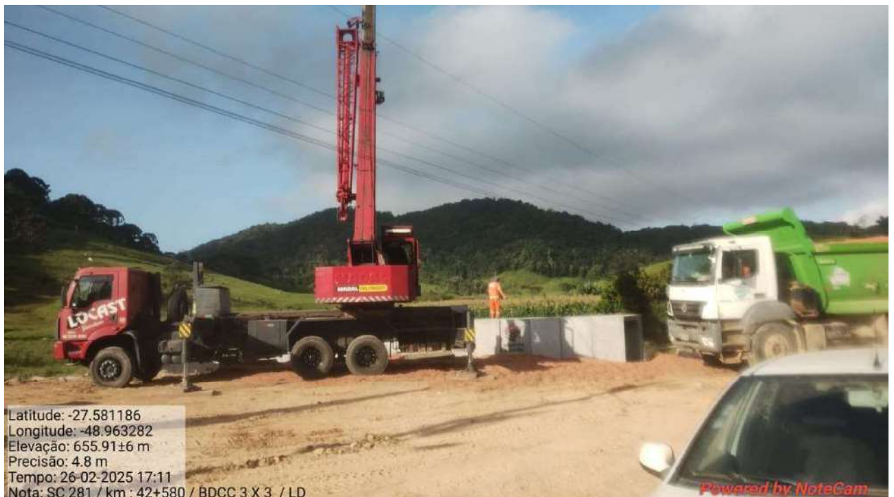
Foto 2 – Lançamento de Aduelas BDCC 3,00x3,00 km 42+580
