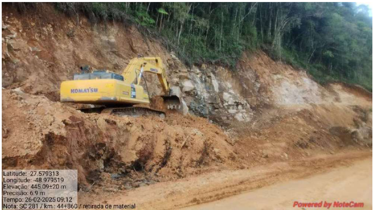
Foto 6 – Escavação de Mat. de 3ª Categoria km 44+860
