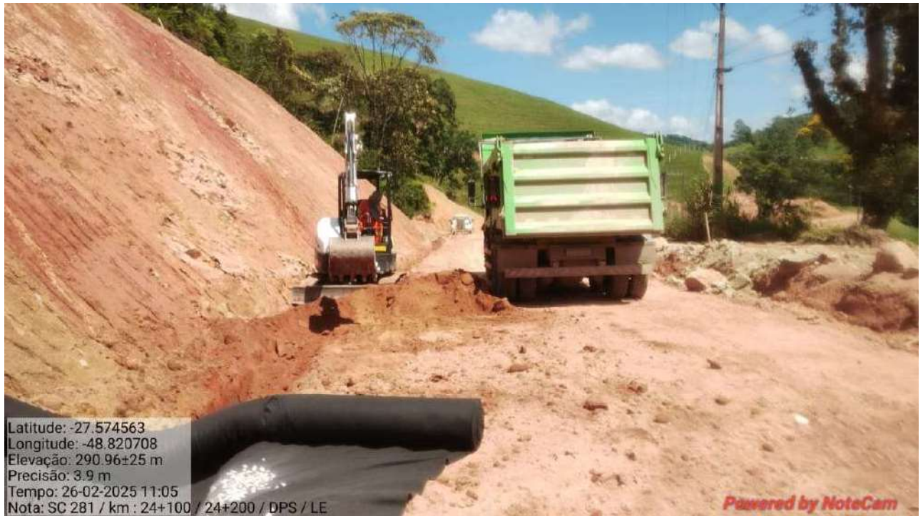
Foto 5 – Execução de Dreno longitudinal - km 24+100
