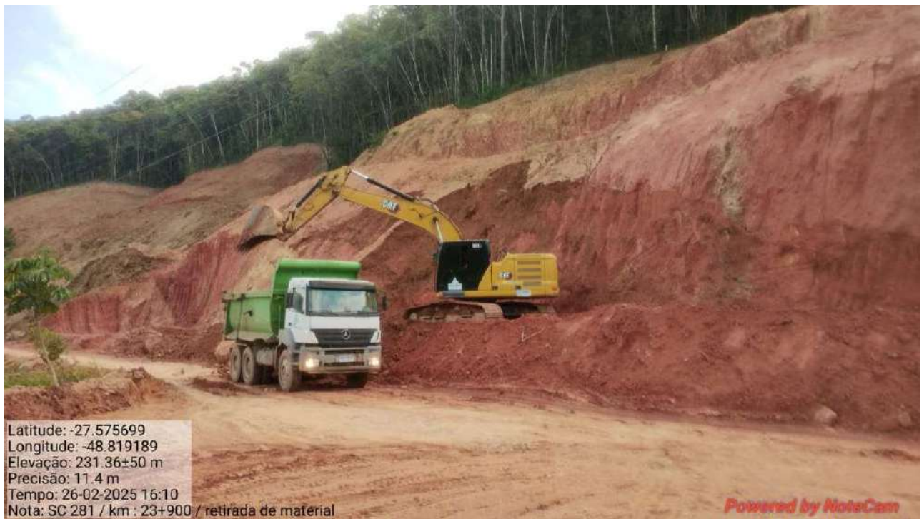
Foto 4 – Escavação de Mat. de 1ª Categoria km 23+900
