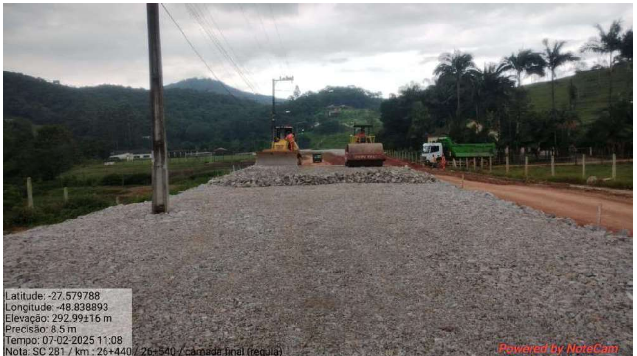
Foto 8 – Execução de Camada Final de Aterro em Rocha - km 26+440
