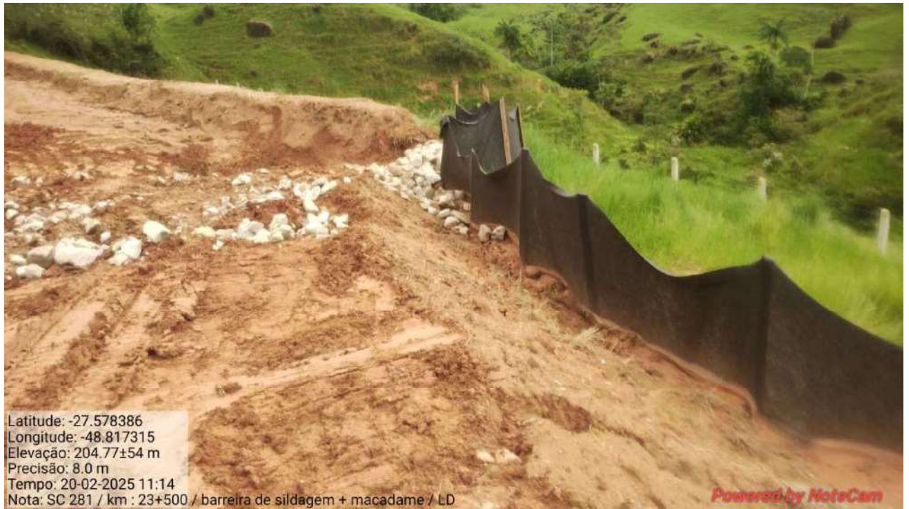
Foto 7 – Execução de Barreira de Siltagem - km 23+500
