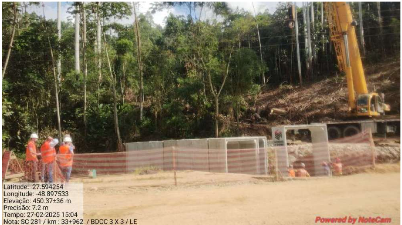
Foto 3 – Lançamento de Aduelas BDCC 3,00x3,00 km 33+962
