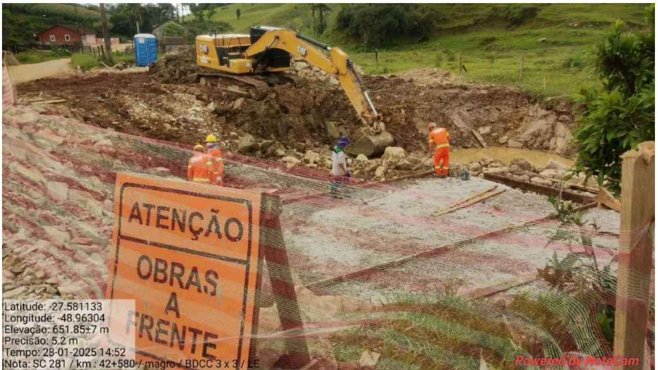
Foto 2 – Execução de desvio e Galeria km 42+580
