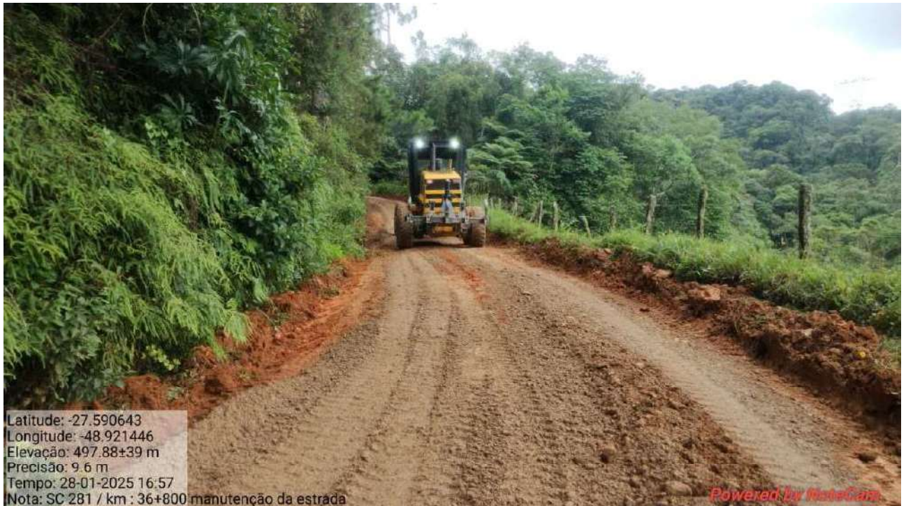
Foto 1 – Serviço de Manutenção da via km 36+800
