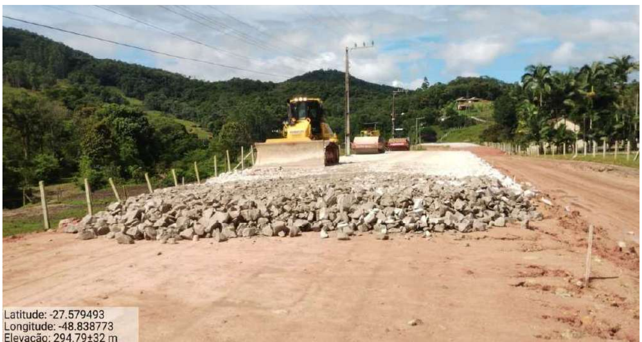
Foto 4 – Camada final de aterro em rocha km 26+400
