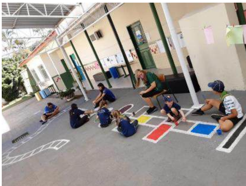
Manutenção e pintura da Escola Vicente da Silveira em Palhoça / SC.
