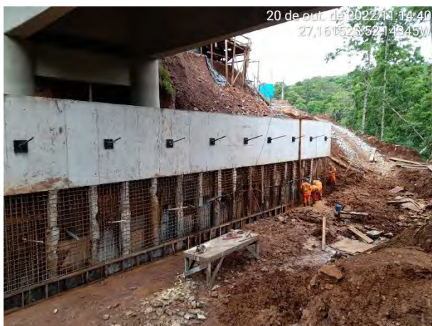
Foto 03 – Execução do muro de contenção
