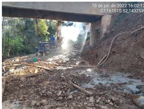
Foto 02 – Execução das fundações contensão
