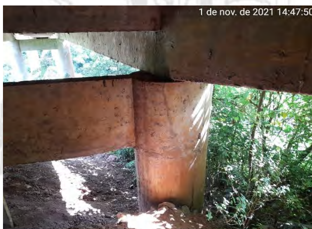
Foto 31 – Pilar Pórtico 01 – Montante
