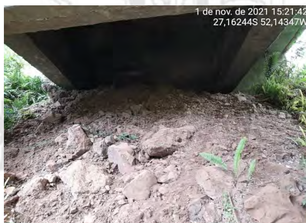
Foto 37 – Vista da Cabeceira Esquerda
