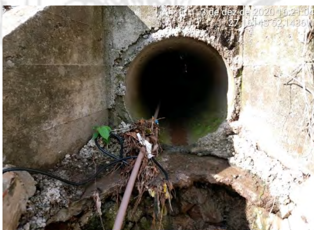
Foto 30 – Vista Sistema de Drenagem - Montante
