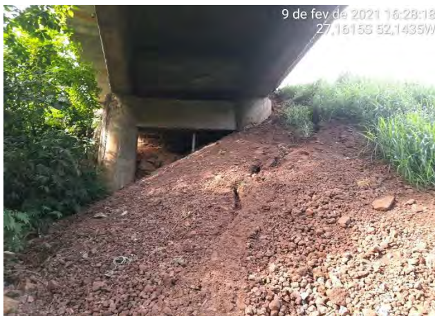
Foto 08 – Aterro Lateral + Mesoestrutura
