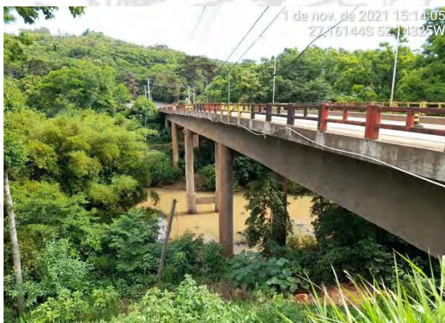
Foto 18 – Vista da Ponte - Jusante
