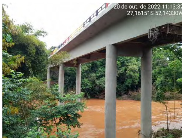
Foto 04 – Pintura da estrutura da Ponte
