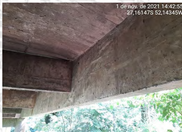
Foto 19 – Junta de Concretagem Viga Longarina
