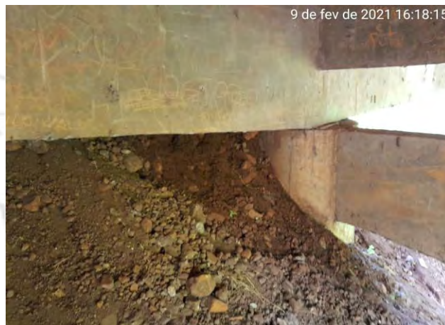
Foto 09 – Aterro Lateral + Mesoestrutura
