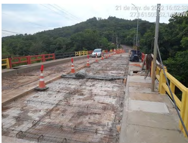
Foto 05 – Recuperação da pista de rolamento
