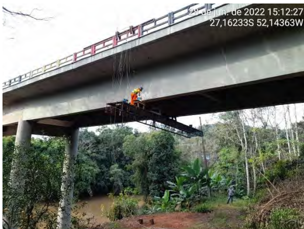
Foto 01 – Limpeza e pintura da estrutura
