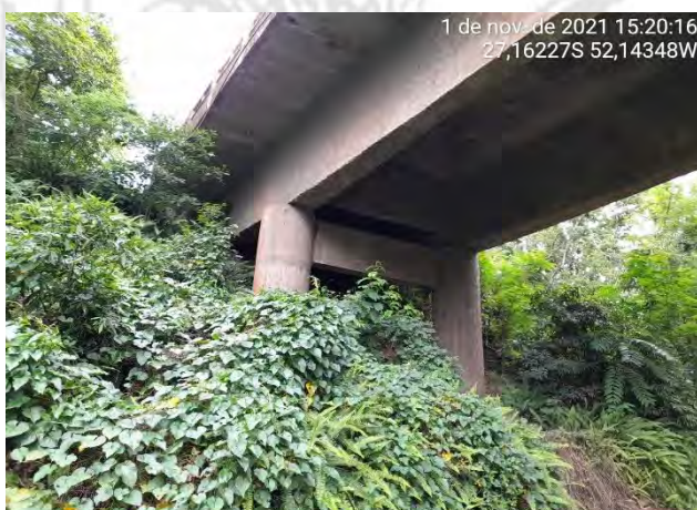
Foto 36 – Vista do Pórtico 06 - Jusante
