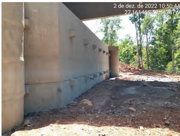
Foto 07 – Muro de contenção da cabeceira
