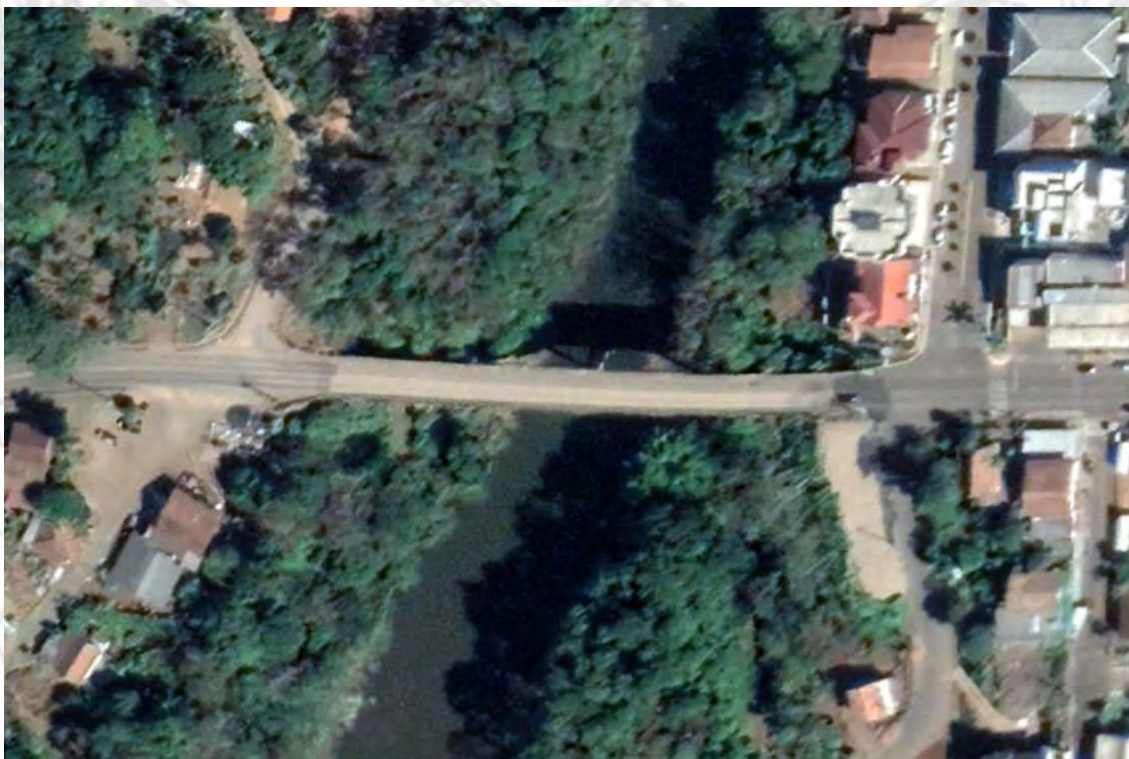
Figura 1: Vista Aérea do Trecho – Fonte Google Earth
