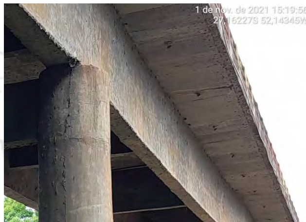
Foto 17 – Vista das Vigas e Passarela
