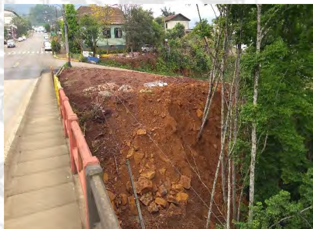
Foto 05 – Aterro Lateral Implantado
