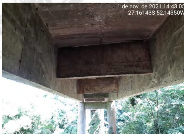
Foto 15 – Vista Vigas Longarinas e Transversinas
