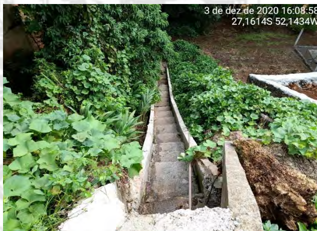
Foto 29 – Vista do Sistema de Drenagem
