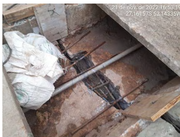
Foto 06 – Recuperação da estrutura da Ponte
