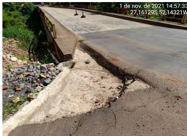
Foto 33 – Coleta das Águas Superficiais - Jusante
