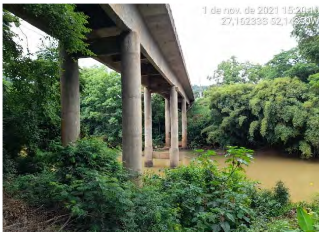
Foto 10 – Mesoestrutura a Jusante
