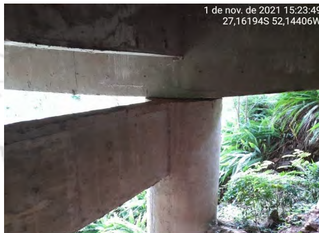
Foto 11 – Apoio da Mesoestrutura
