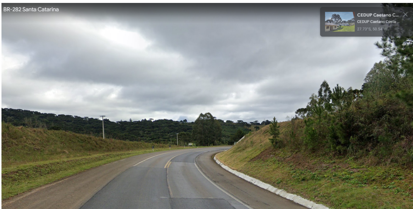
Imagem 2: BR-282/SC sentido Lages - São José do Cerrito (visibilidade extremamente reduzida)
