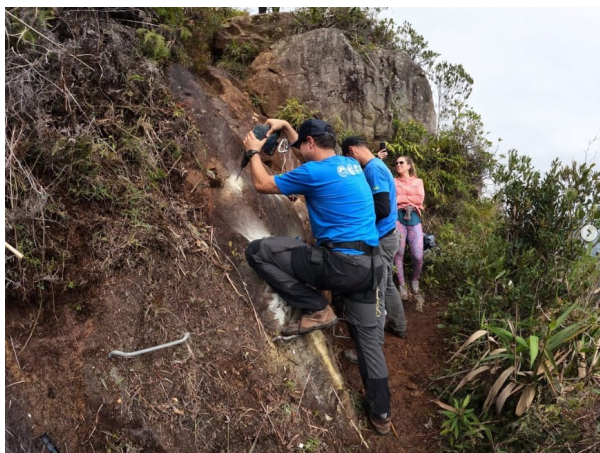
Figura 4.4 - Instalação de degraus
