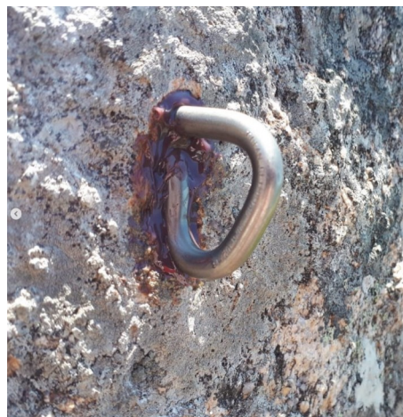
Figura 2.3 - Grampo de titânio instalado.
