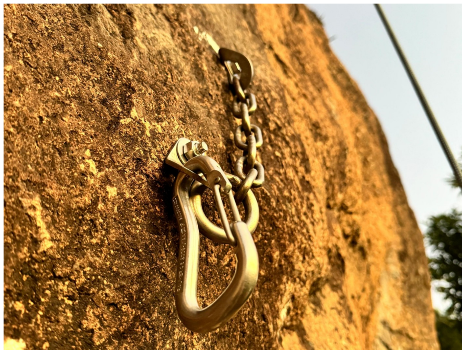
Figura 5.1 - Instalação de nova parada na Zé Colmeia.
