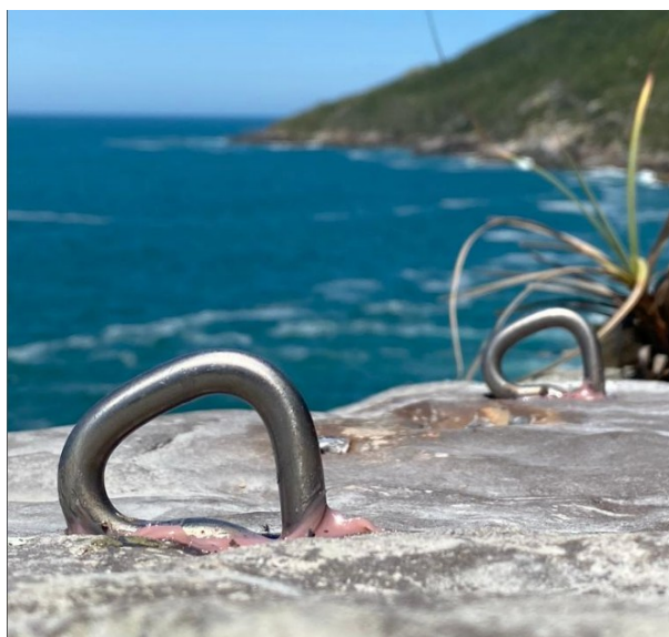
Figura 4.8 - Grampo de Titânio instalado
