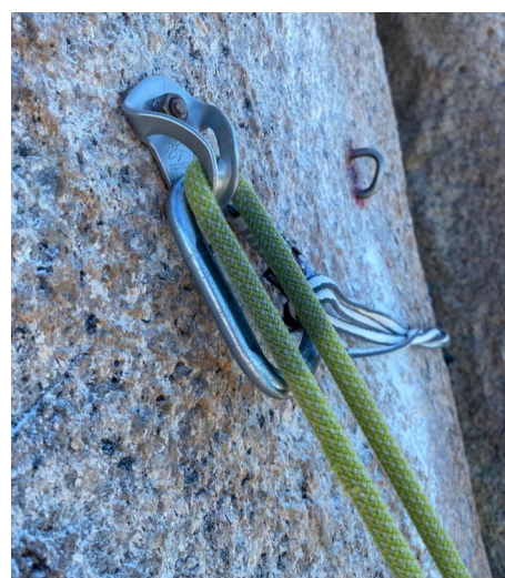
Figura 2.9 - Grampo de titânio instalado.
