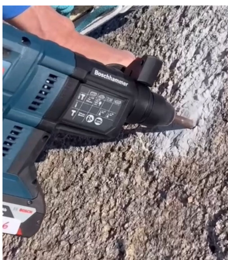
Figura 2.8 - Instalação do grampo de titânio
