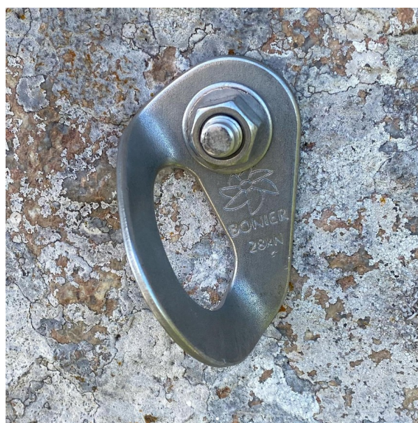
Figura 2.6 - Chapeleta nova instalada.
