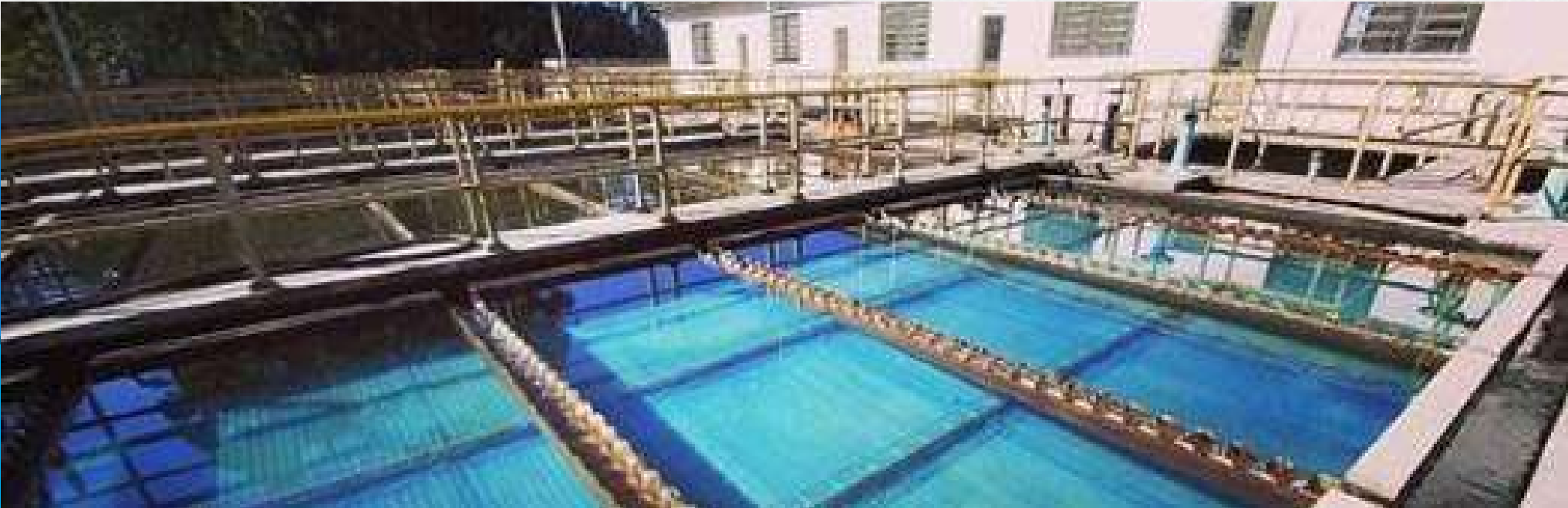
Estação de Tratamento de Água de Criciúma
