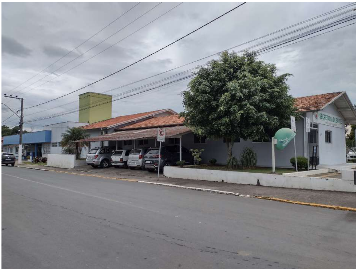
Figura 01: Vista Geral do Bem Imóvel.
