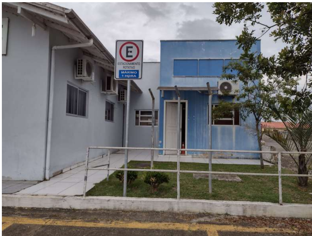
Imagem 3 - Vista pela Avenida Presidente Kennedy do depósito
