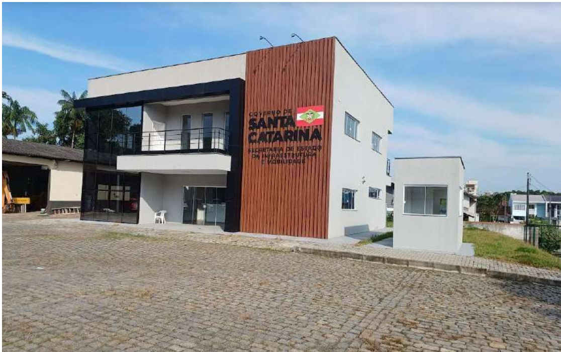
Figura 7 – Edificação da Secretaria de Infraestrutura e Mobilidade – Sede Nova.
