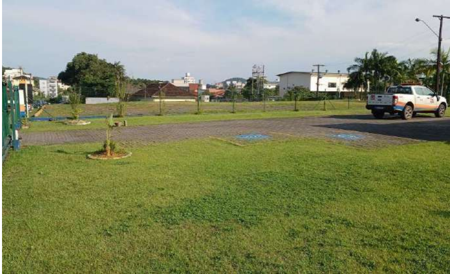
Figura 17 - Acesso a edificação do CIGERD - Defesa Civil, pavimentado em paver, com área aproximada de 189,17 m 2 .
