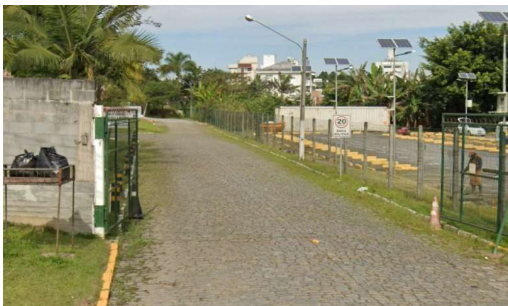
Figura 16 – Estrada de Acesso Rua Izaltino Machado e rua transversal de acesso as edificações, com área aproximada de 1516,11 m 2 .
