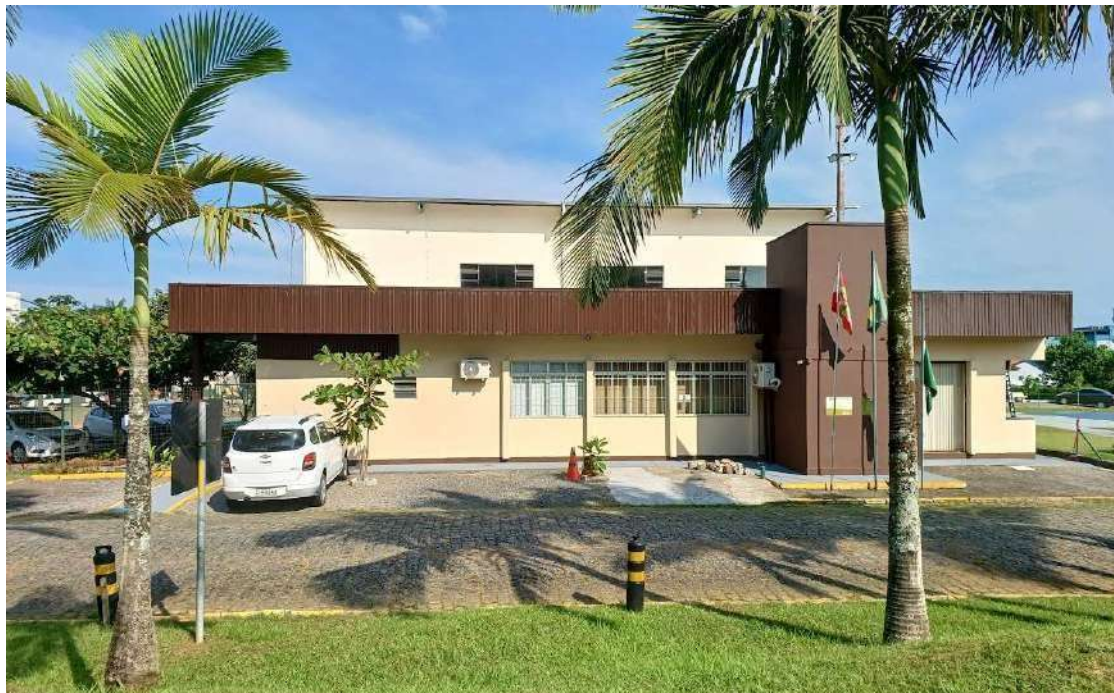
Figura 4– Edificação da 2ª CIA - Base Avançada Graer.
