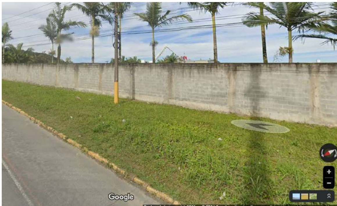
Figura 21 – Muro de Divisa com a Rua Arno Waldemar Doheler.
