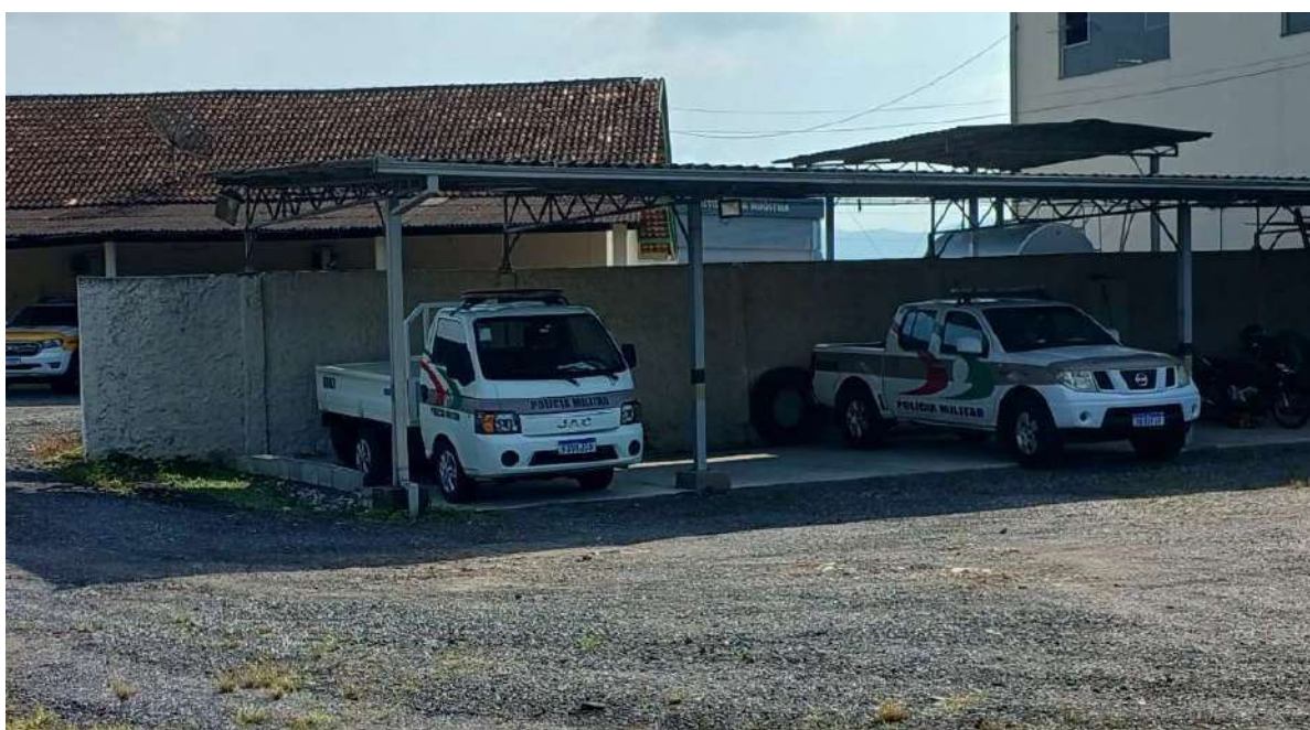
Figura 22 – Muro de Divisa entre a edificação da polícia militar rodoviária e garagem do Graer.
