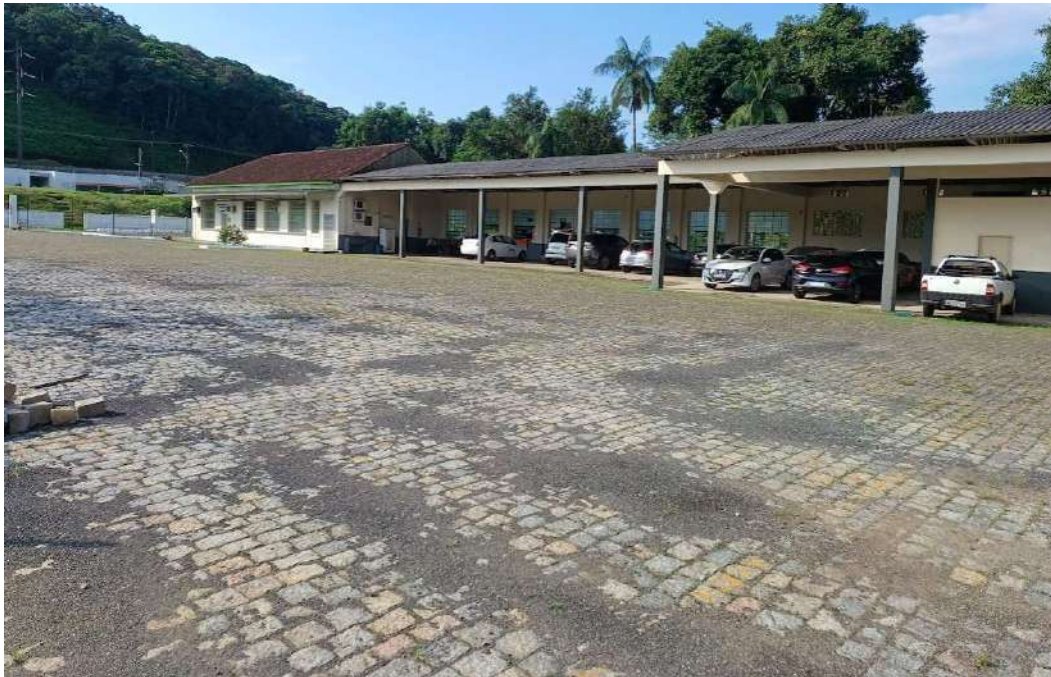
Figura 15 – Pátio de Acesso as edificações da Secretaria de Infraestrutura e Mobilidade, com área aproximada de 2237,79 m 2 .
