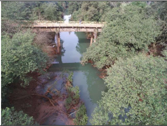
Vista de montante
