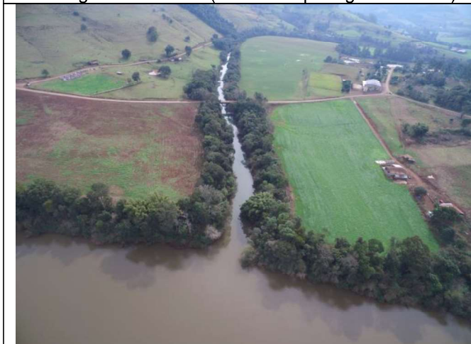
Vista geral da ponte (vista de jusante)
