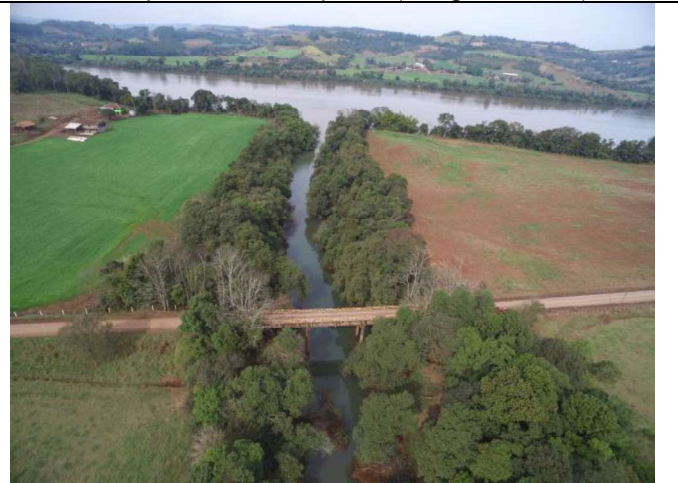
Vista geral da ponte (vista de montante)
