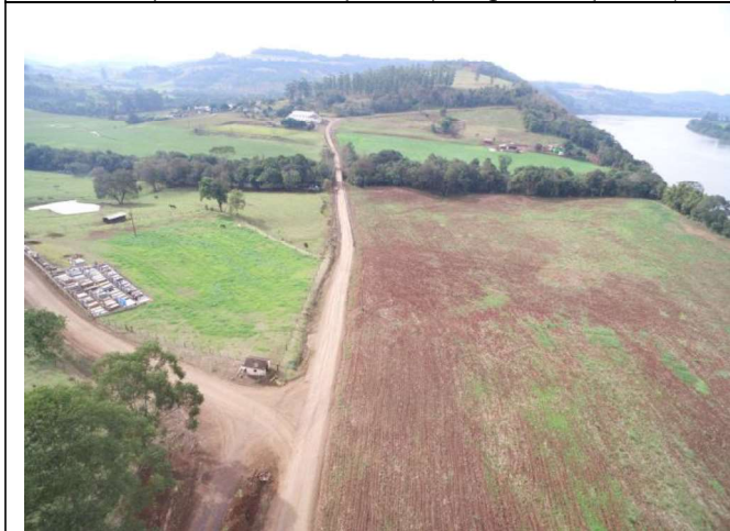
Vista geral do trecho (sentido Itapiranga – Mondai)
