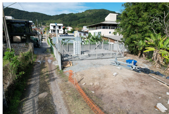
Foto 08 - Local de instalação da antena.
