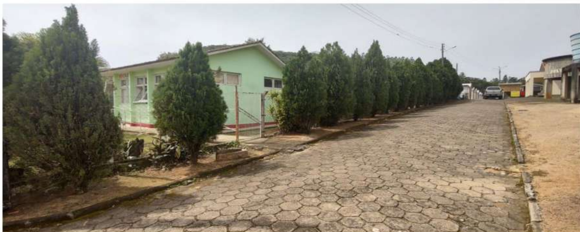
Foto 2 – Vista Externa Frontal da edificação
