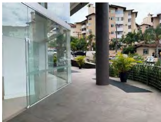
F17 – Vista circulação em frente ao edifício
