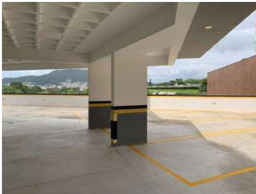
F45 – Pav. pilotis – garagens e circulação
