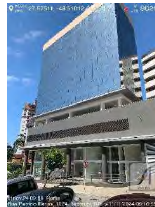
F08 – Vista da fachada – parcial
