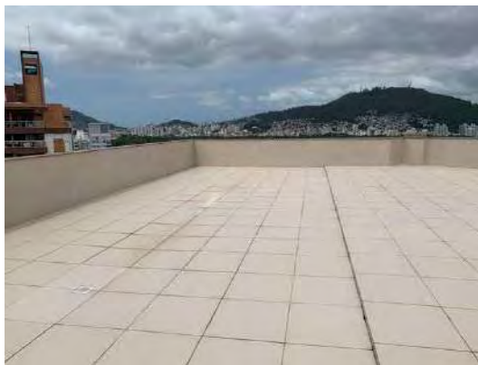
F63 – Cobertura do pav. ático
