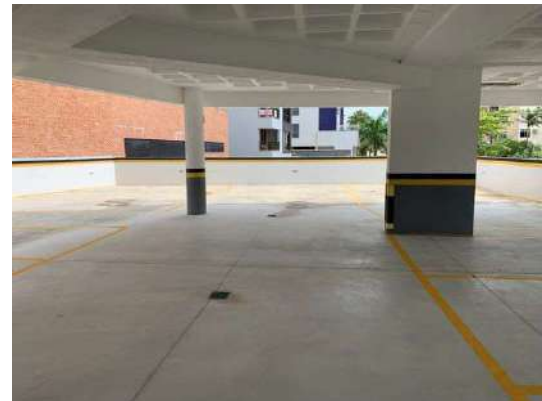
F40 – Pav. pilotis – garagens e circulação
