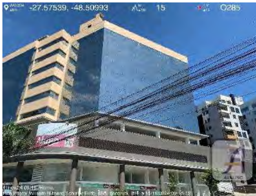
F07 – Vista da fachada – parcial
