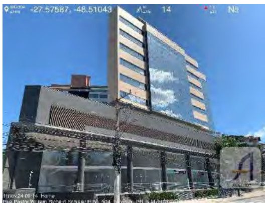
F05 – Vista da fachada – parcial
