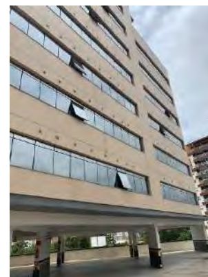
F12 – Vista parcial fachada de fundos
