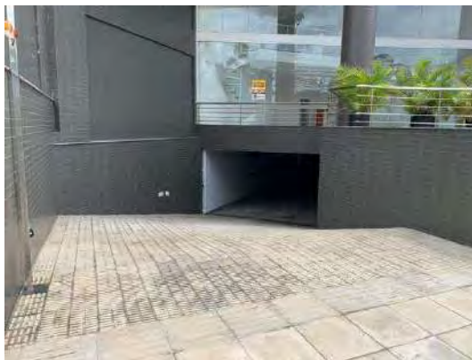
F09 – Acesso ao subsolo
