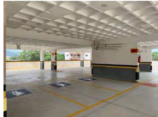
F44 – Pav. pilotis – garagens e circulação
