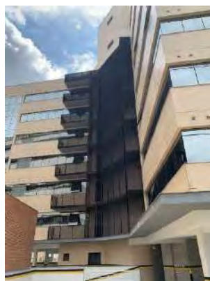
F11 – Vista parcial fachada de fundos
