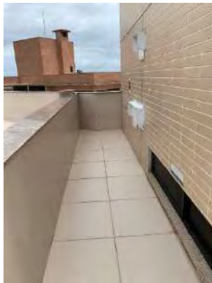
F61 – Cobertura do pav. ático
