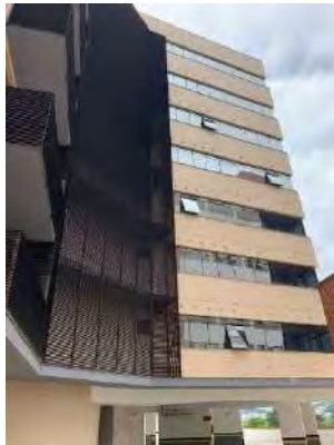
F13 – Vista parcial fachada de fundos
