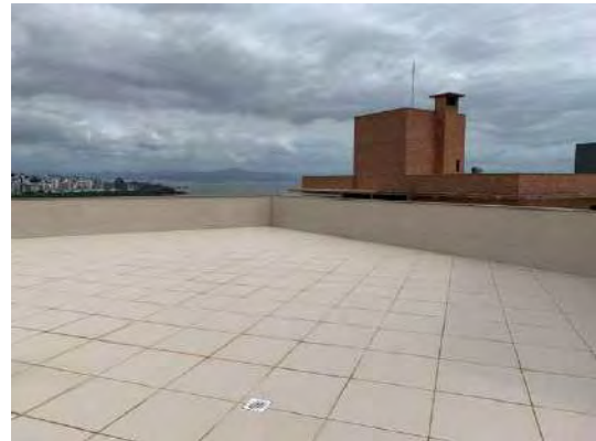
F62 – Cobertura do pav. ático
