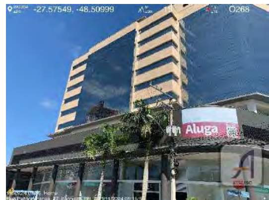
F06 – Vista da fachada – parcial
