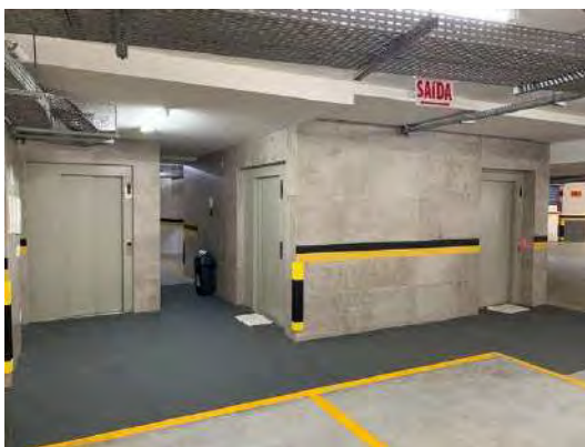
F23 – Subsolo – acesso elevadores
