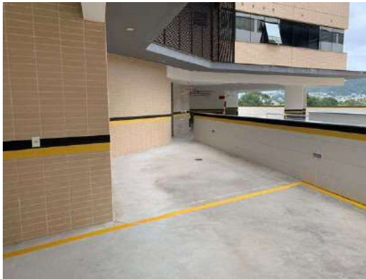
F43 – Pav. pilotis – garagens e circulação
