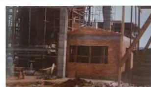
Anos 80: Construção da caldeira gaza
