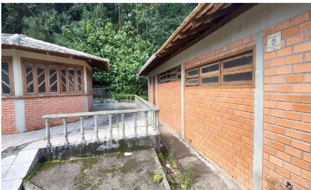
Vestiários junto ao salão de festas 2 – vista externa
