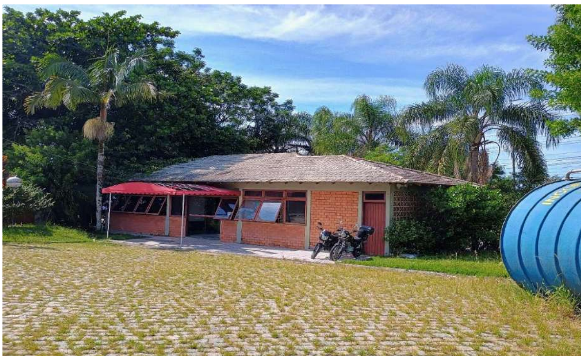
Bloco Administrativo – vista externa
