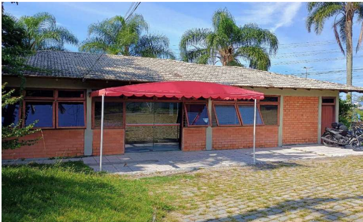
Bloco Administrativo – vista externa
