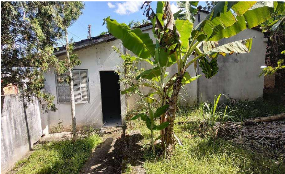
Casa de apoio – vista externa
