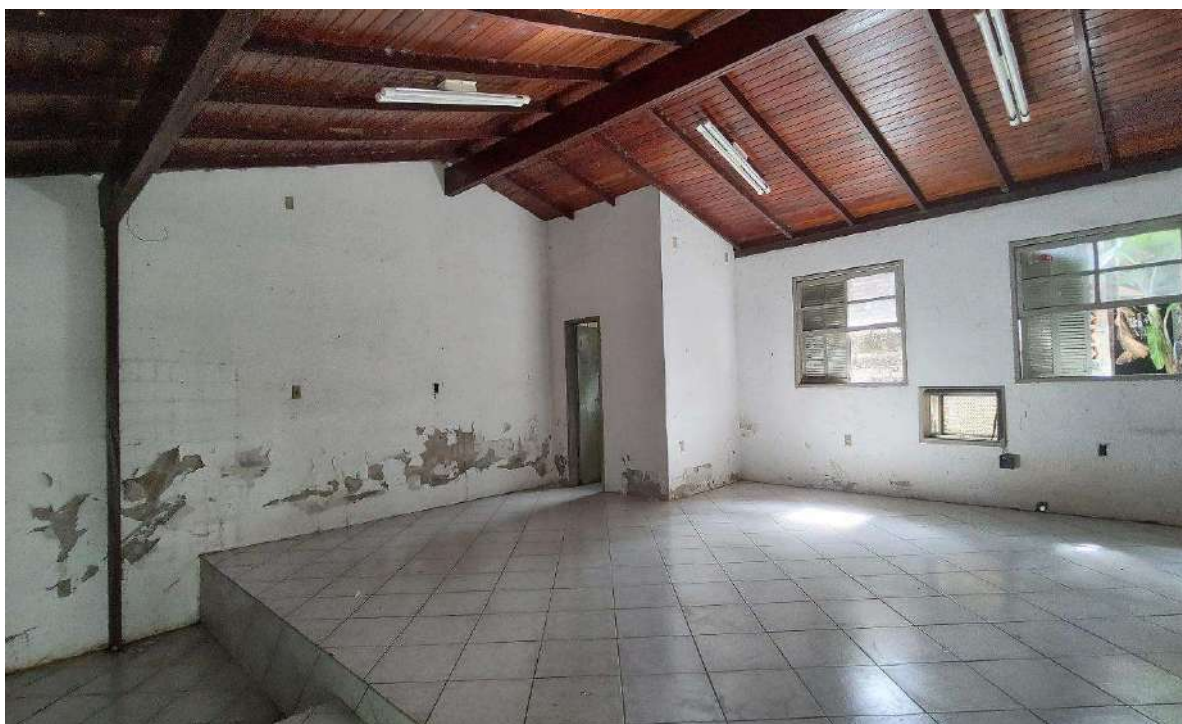
Casa de apoio – vista interna
