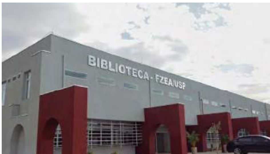
NOVO PRÉDIO DA BIBLIOTECA DA FACULDADE DE ZOOTECNIA E ENGENHARIA DE ALIMENTOS FOTO: CECILIA BASTOS/USP IMAGENS
