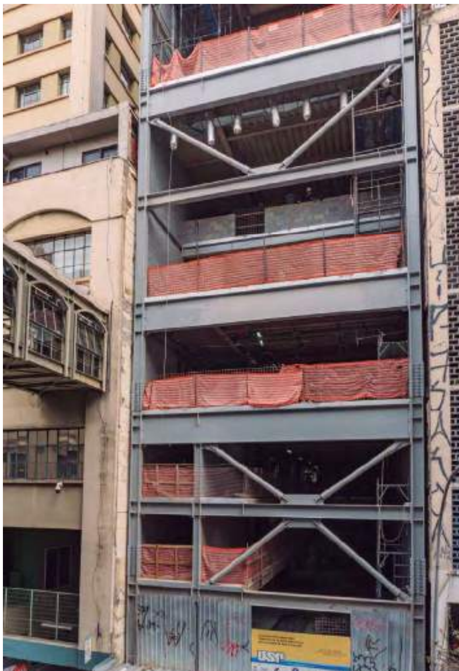
OBRAS NA BIBLIOTECA DA FACULDADE DE DIREITO, EM SETEMBRO DE 2025 FOTO: SUPERINTENDÊNCIA DO ESPAÇO FÍSICO
