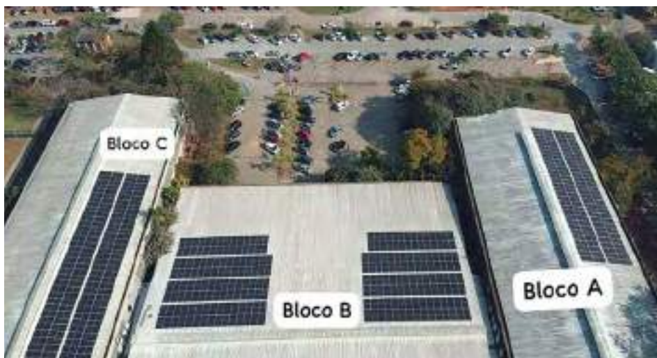
SISTEMA SOLAR DO EDIFÍCIO DO DEPARTAMENTO DE ELÉTRICA DA POLI FOTO: DIVULGAÇÃO
