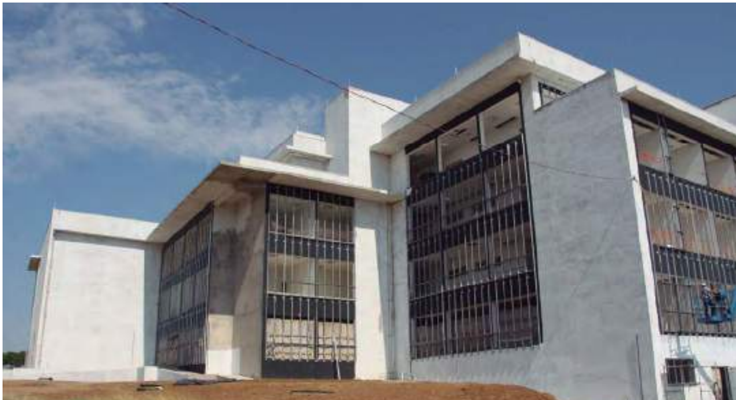
NOVO PRÉDIO DO CENTRO DE PESQUISA EM ÓPTICA E FOTÔNICA (CEPOF) ESTÁ EM FASE FINAL DE ACABAMENTO FOTO: IFSC/USP
