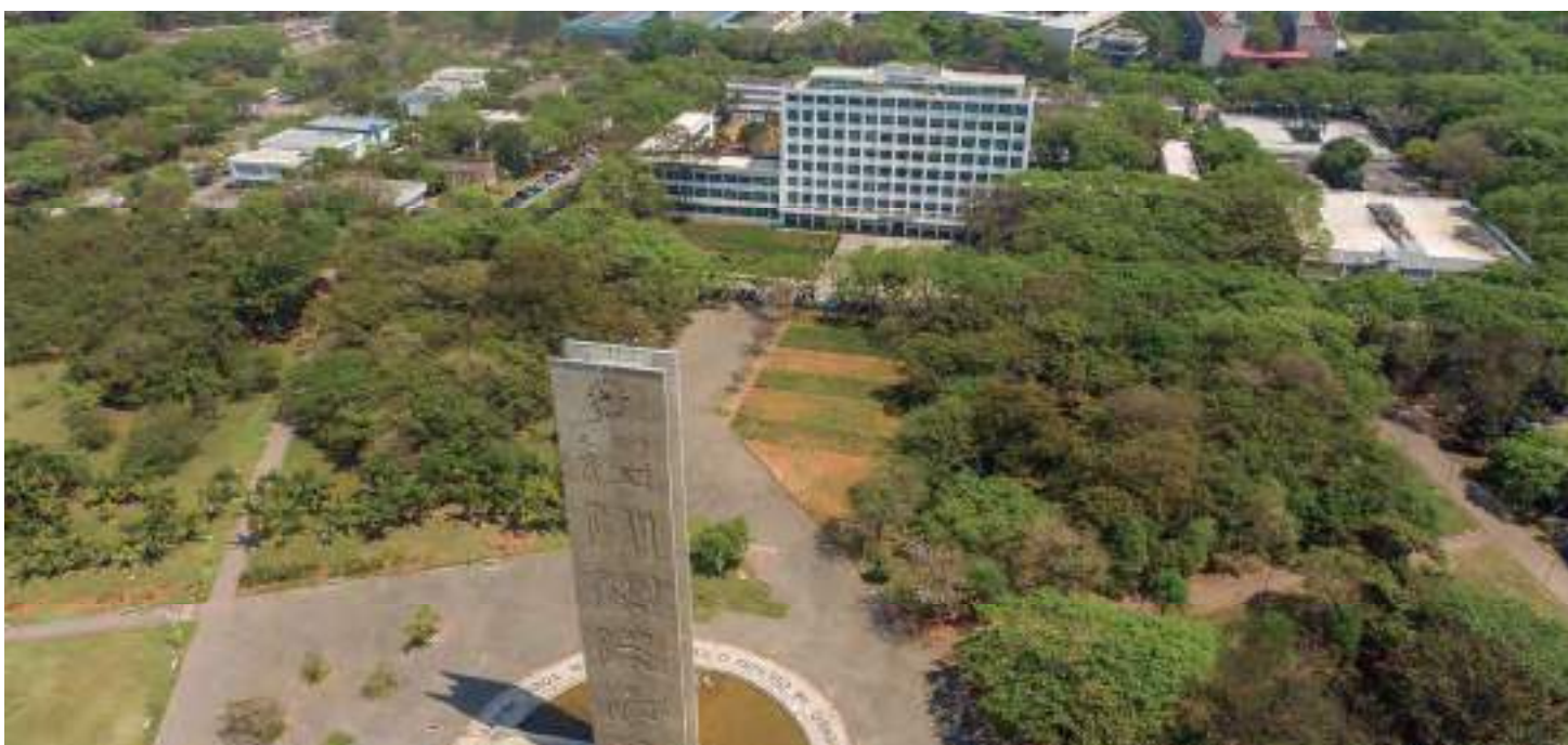
PRÉDIO DA REITORIA E PRAÇA DO RELÓGIO, NA CIDADE UNIVERSITÁRIA FOTO: CECÍLIA BASTOS/USP IMAGENS
