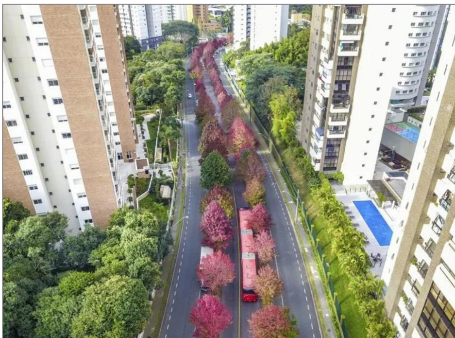
Av. Dep. Heitor Alencar Furtado em Curitiba: duas faixas por sentido + corredor central.
