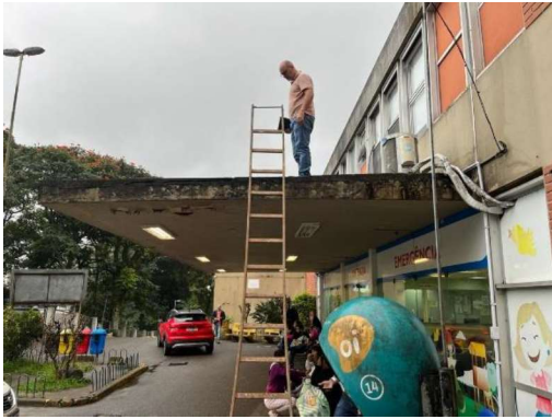
Fotografia 2: Vista da marquise de cobertura da entrada de emergência
