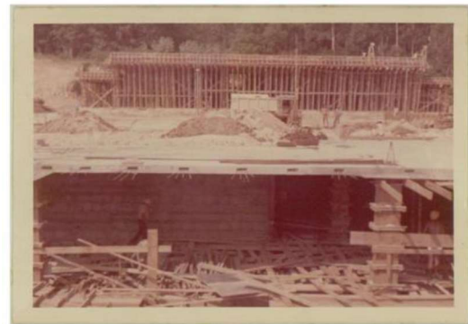
Fotografia 4 – Registro do sistema protensão da estrutura
