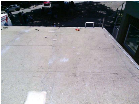
Fotografia 13 – Vista da laje da emergência
