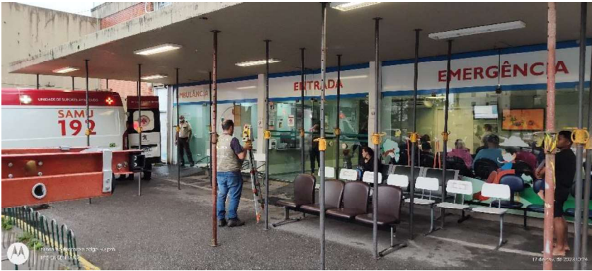
Fotografia 25 – Execução do levantamento topográfico na laje.
