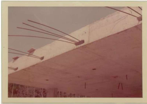
Fotografia 5 – Detalhamento das cordoalhas que compõem a estrutura do hospital
