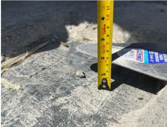
Fotografia 23 – Verificação da espessura da proteção mecânica
