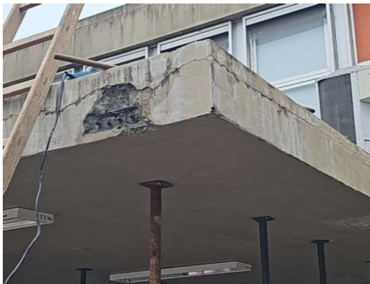
Fotografia 19 – Inspeção nas Cordoalhas
