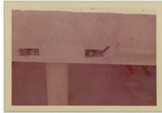
Fotografia 6 – Detalhamento das cordoalhas que compõem a estrutura do hospital
