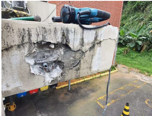
Fotografia 37 – Inspeção nas Cordoalhas
