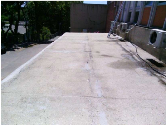
Fotografia 31 – Vista da laje da emergência
