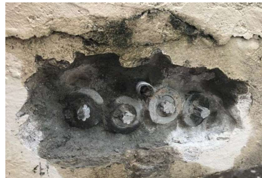
Fotografia 20 – Detalhe da Inspeção
