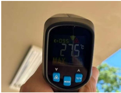
Fotografia 17 – Leitura do Termômetro na face inferior
