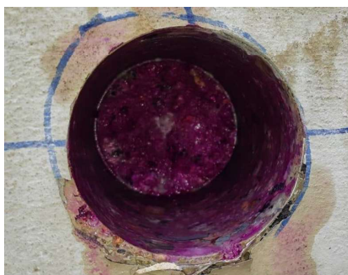
Foto 07: Marquise Emergência - Frente
