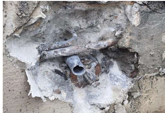
Fotografia 38 – Detalhe da Inspeção
