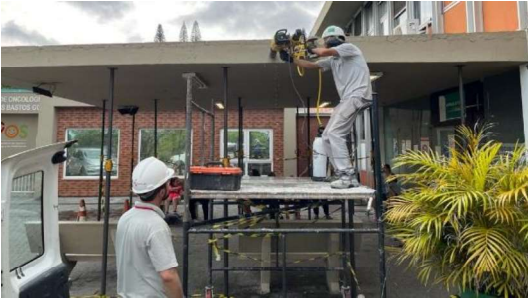
Fotografia 9 – Extração de corpo de prova para ensaio de resistência do concreto.
