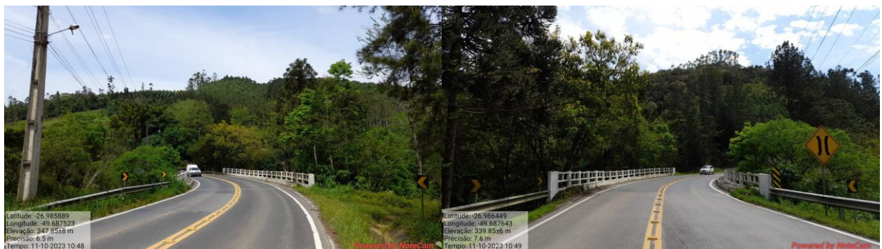
Ponte sobre o Rio Dona Emma (SC-340 - km 213,440)
