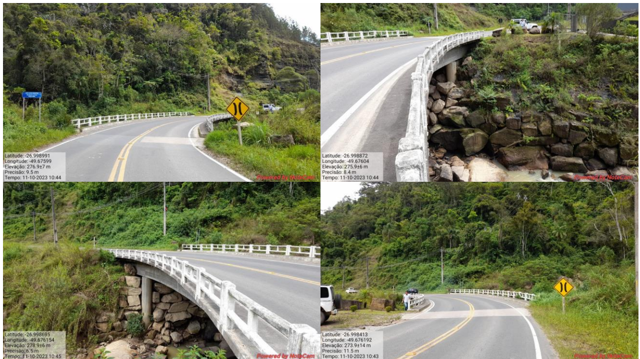
Ponte sobre o Ribeirão Divisa (SC-340 – km 215,700)
