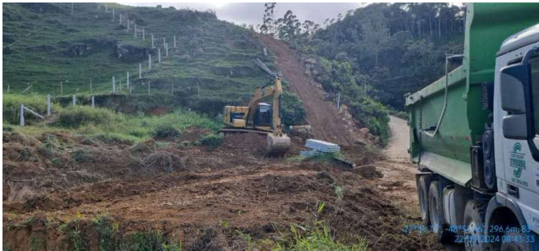
Início dos Serviços escavação no km 29+000
