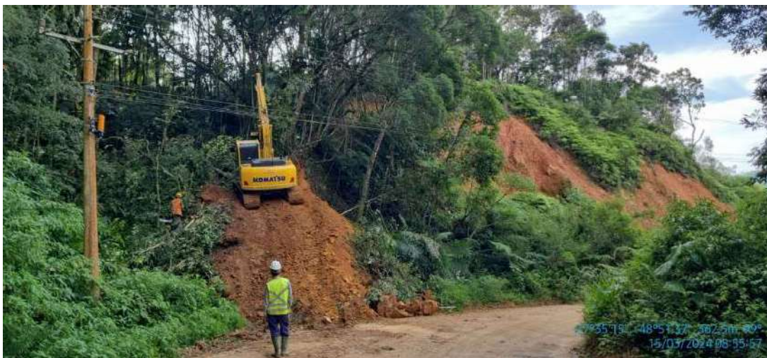
Serviços de Limpeza, corte de árvores e destocamento no km 29+200
