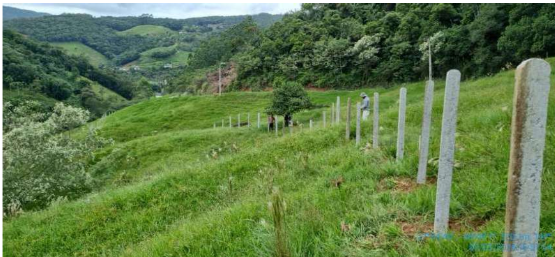
Serviços de execução de cercas km 24+200
