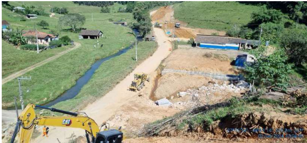
Foto 1 – Imagem geral do canteiro de obras
