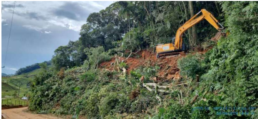
Foto 2 – Desmatamento e Limpeza de Terreno
