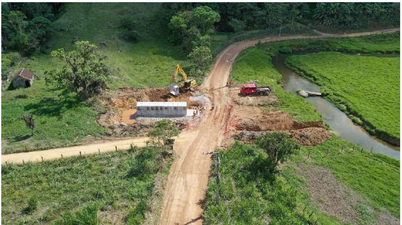
Foto 2 – Execução de BSCC 2,00 x 2,00 – 24+715
