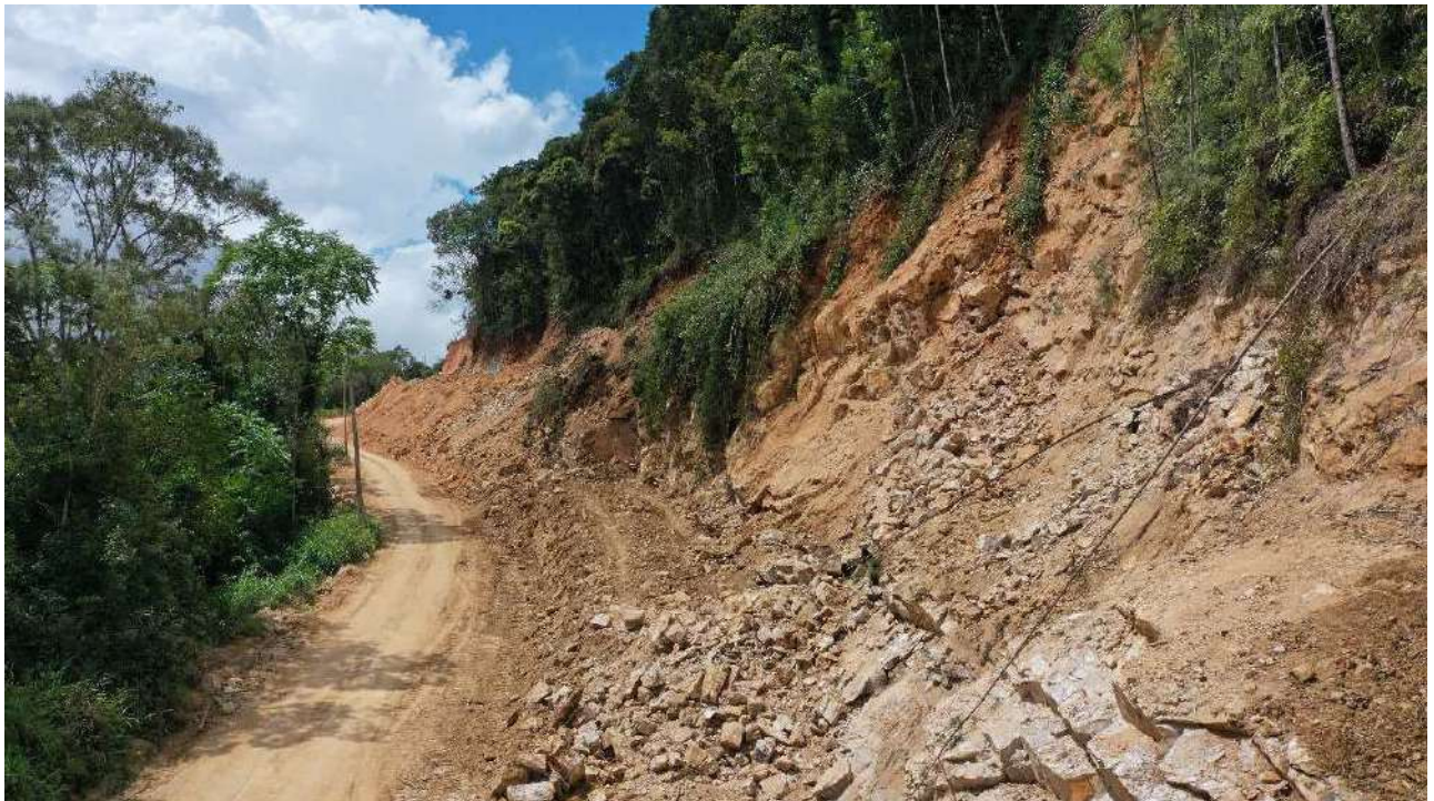
Foto 3 – Escavação de Material de 3ª Cat. km 44+900
