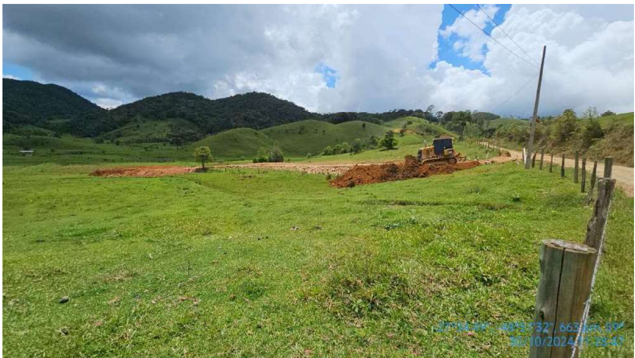
Foto 4 –Espalhamento Bota-Fora km 42+200
