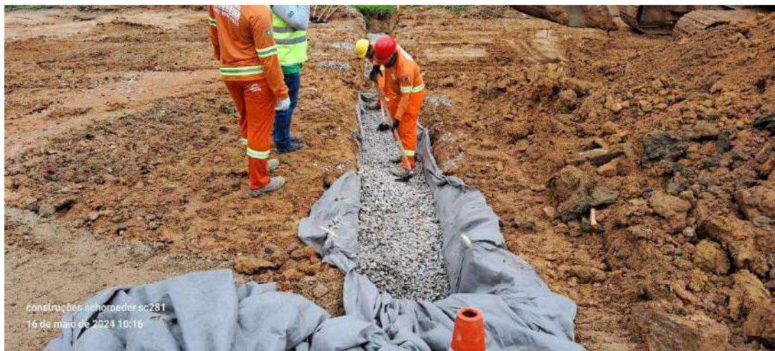
Foto 2 – Execução de dreno transversal (km – 29+100)
