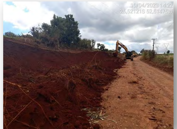
Execução de limpeza e terraplenagem
