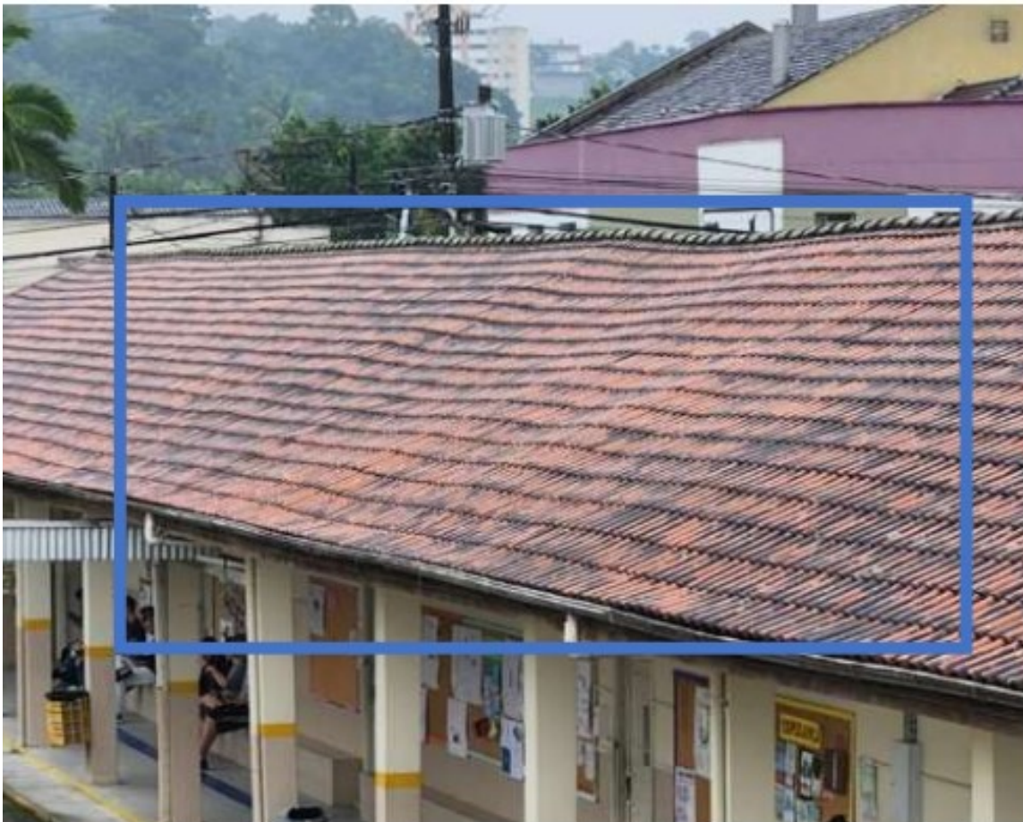
Telhado da escola
