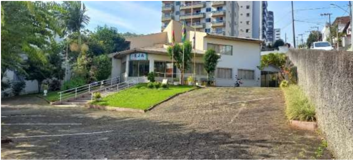
Foto 03 - Vista do EJA – UD Capinzal
