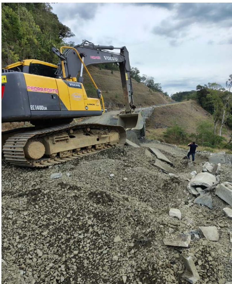
Estabilização do Muro Terrae
