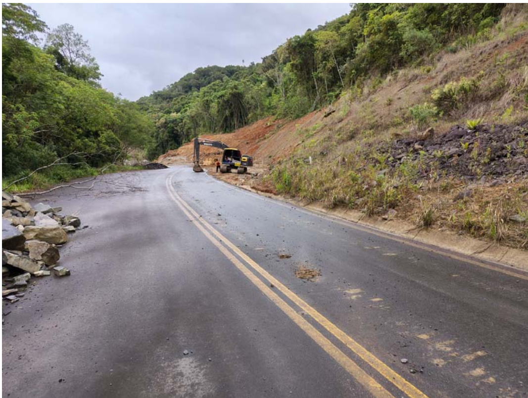
Estabilização do Corte/Aterro
