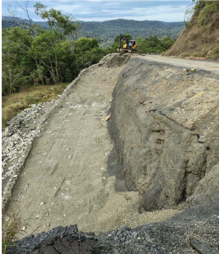
Estabilização do Muro Terra
