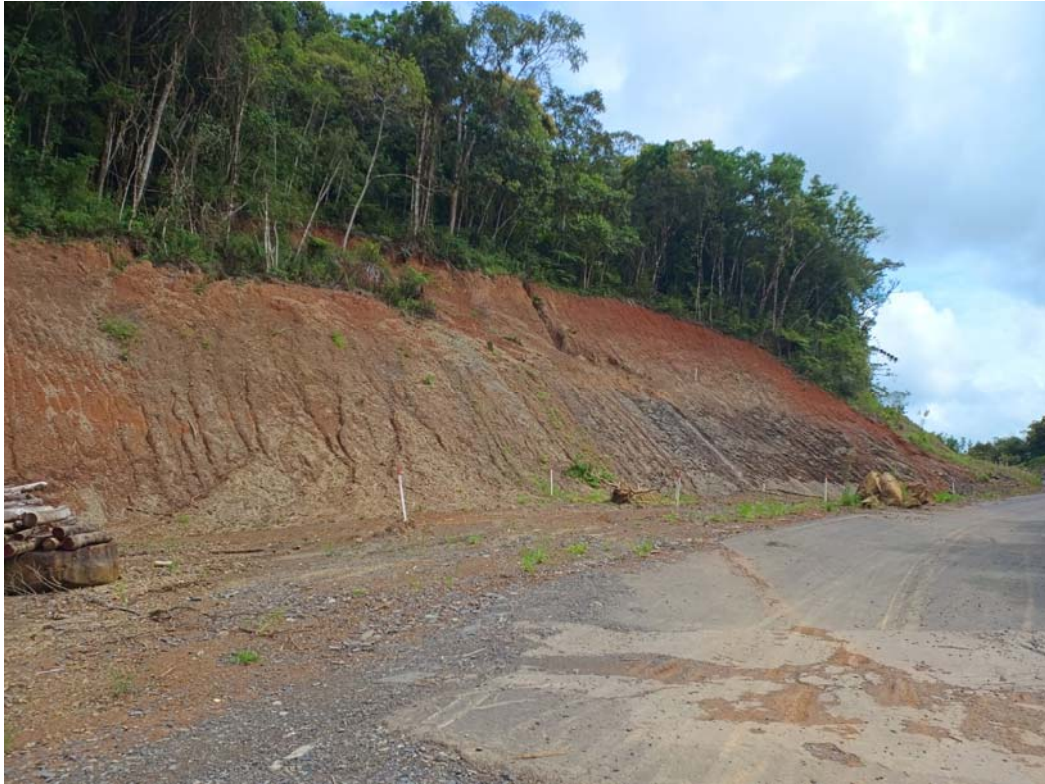
Estabilização do Corte/Aterro
