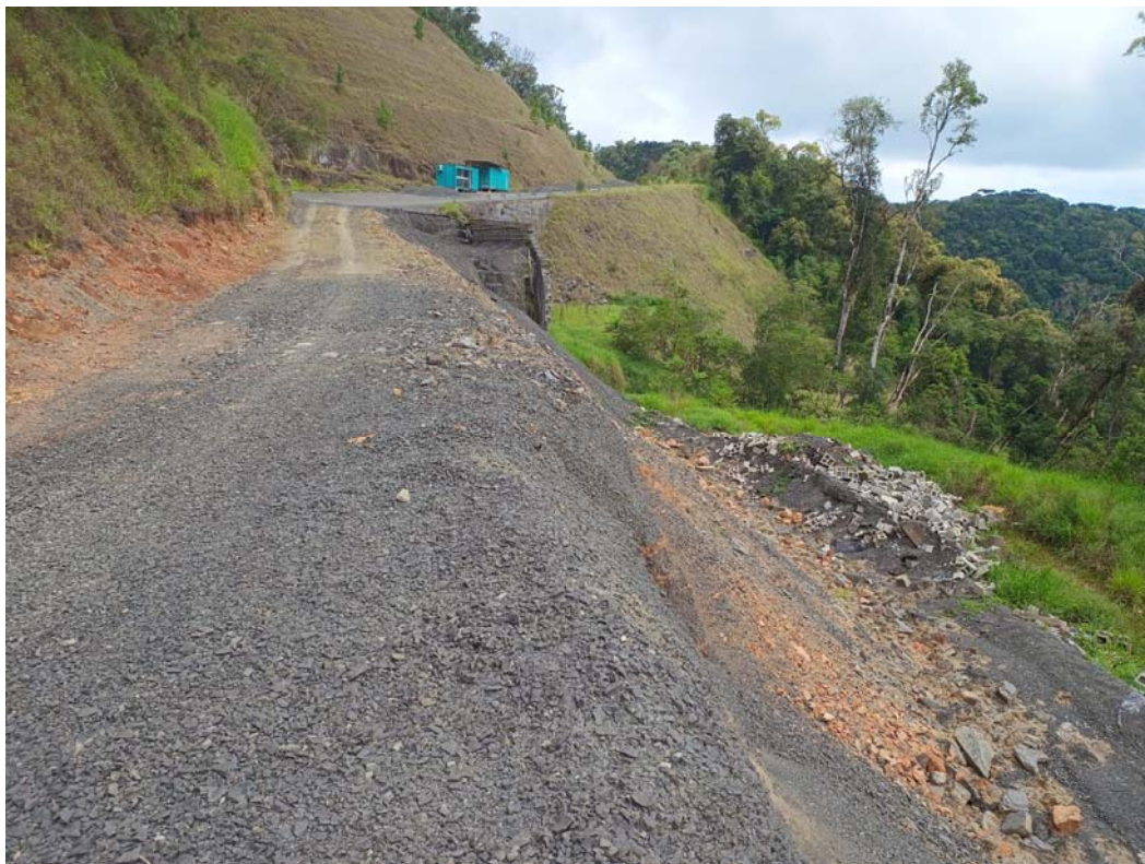
Estabilização do Muro Terra
