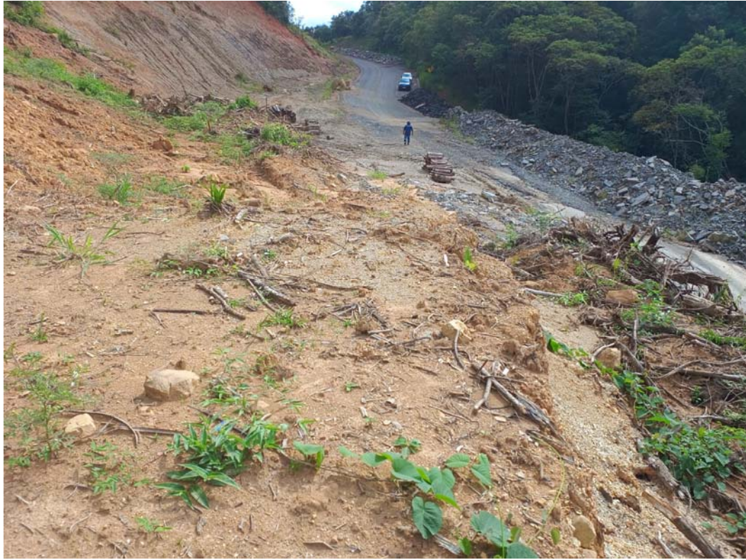
Estabilização do Corte/Aterro
