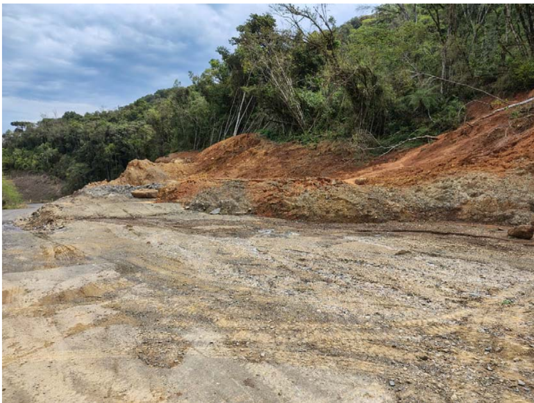
Estabilização do Corte/Aterro
